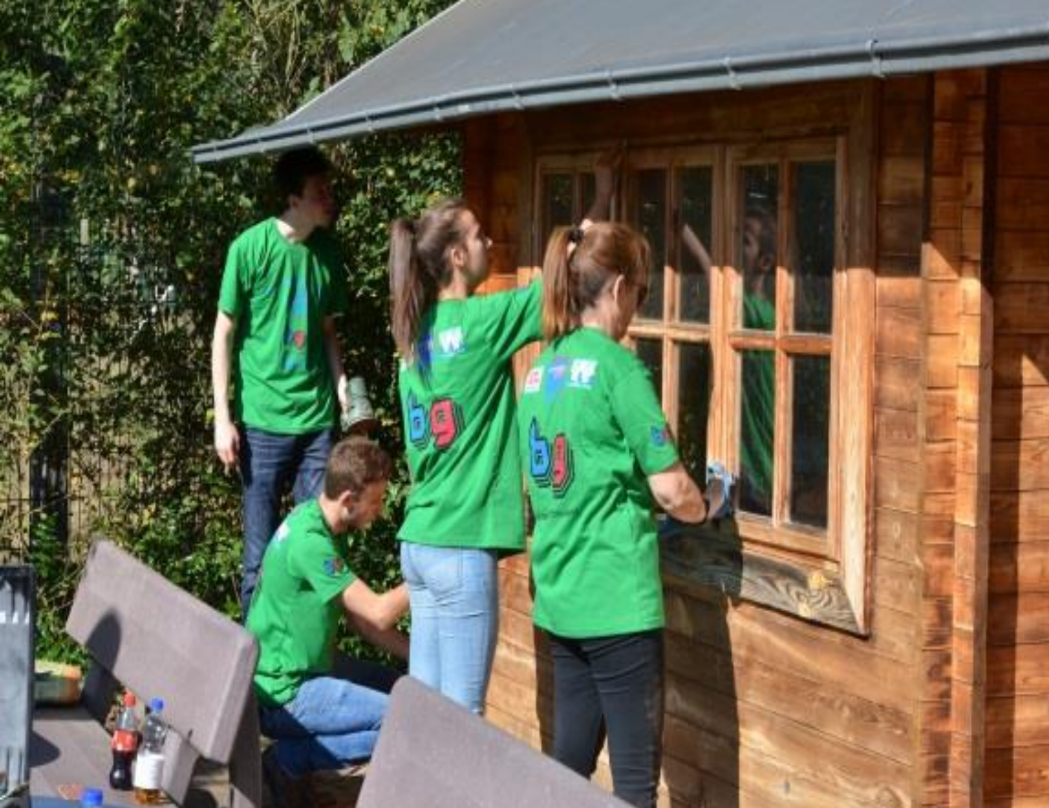
Beispiel: Renovierung der Vereinshütte
