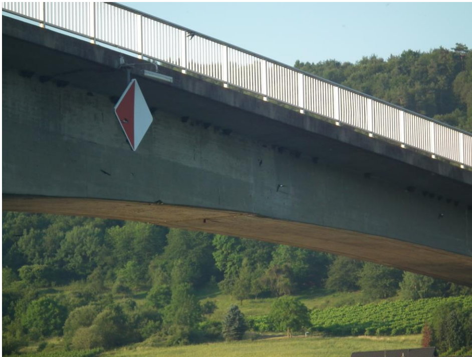
Abbildung 1: Mehlschwalbenkolonie an der Moselbrücke Kinheim
