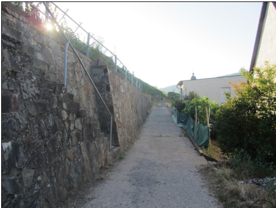
Abbildung 48: Objektschutz durch Aufkantung
