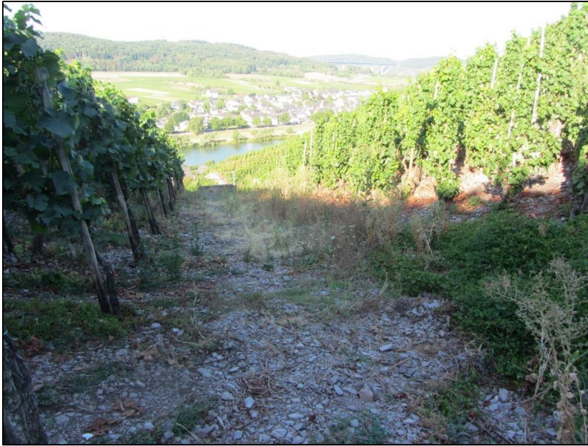
Abbildung 39: Zuwegung zu den Bauwerken mit viel Lockermaterial
