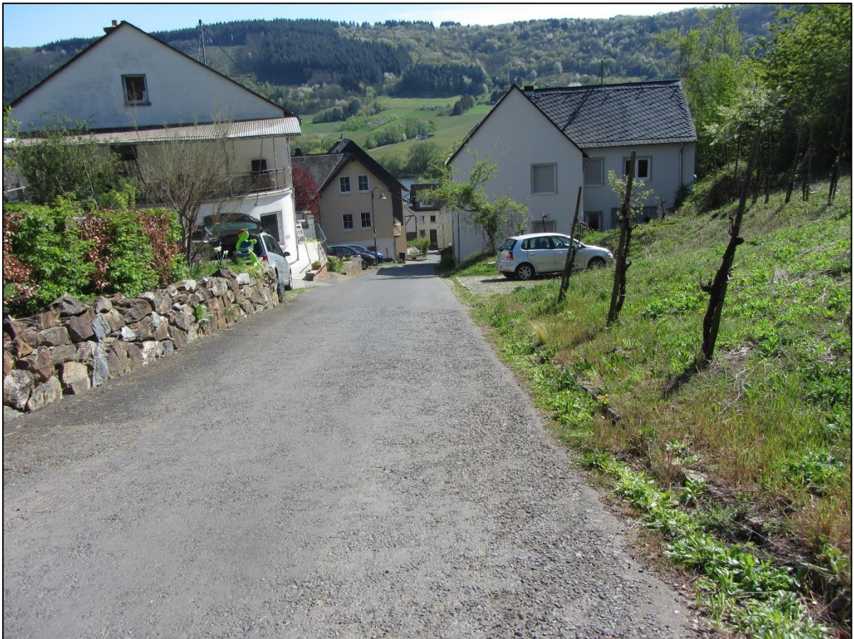
Abbildung 54: Zugewachsene Entwässerungsrinne
