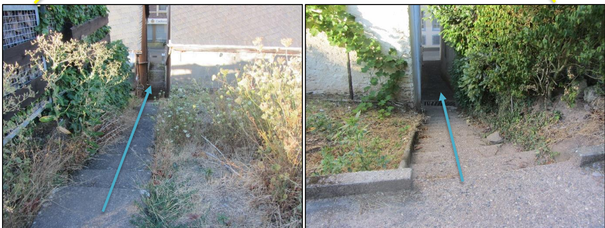
Abbildung 46: Entwässerung des „Ortsrandweges“
