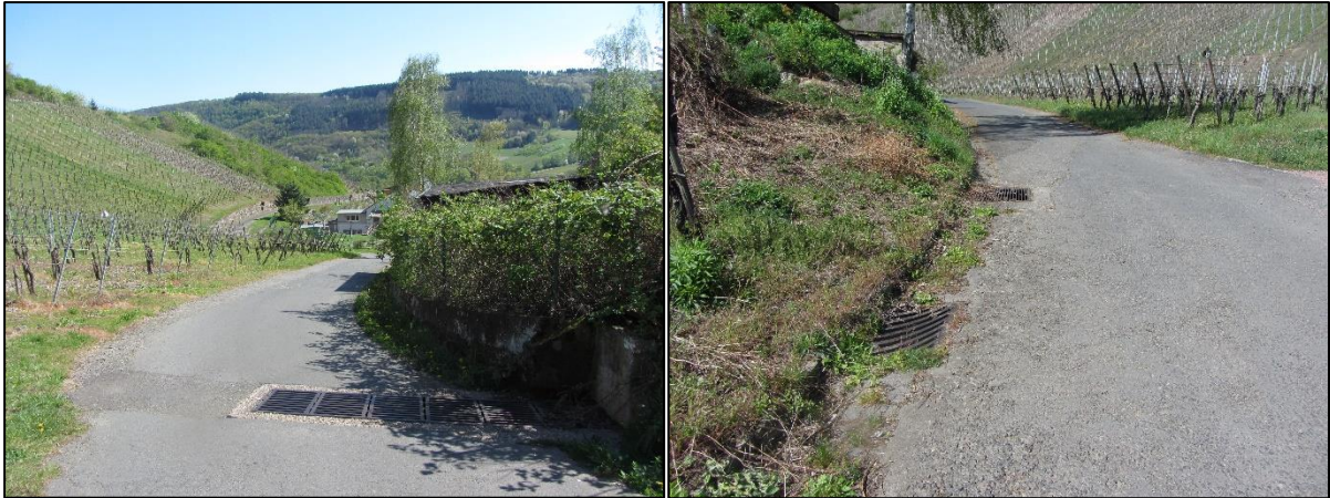
Abbildung 53: Große Einlaufbauwerke auf dem Wirtschaftsweg oberhalb der Borgasse
