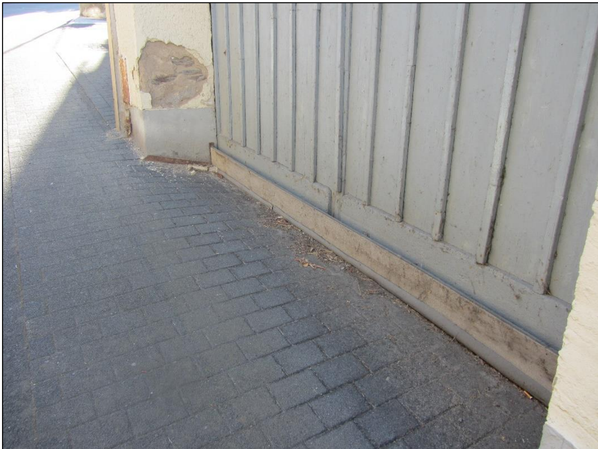
Abbildung 55: Bereits umgesetzte Objektschutzmaßnahme
