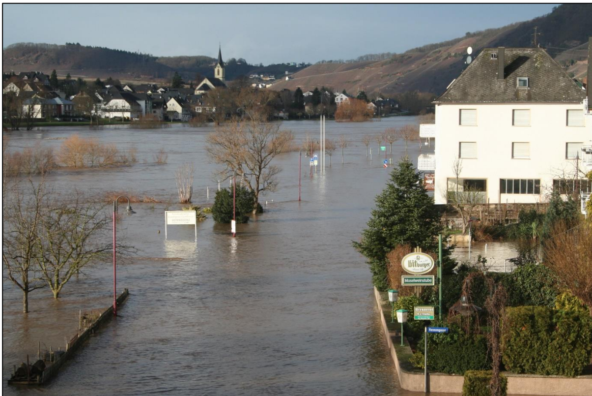
Abbildung 33: Überflutete Moselweinstraße, Hochwasser 2011 (Fotos: KLINK, 2011)
