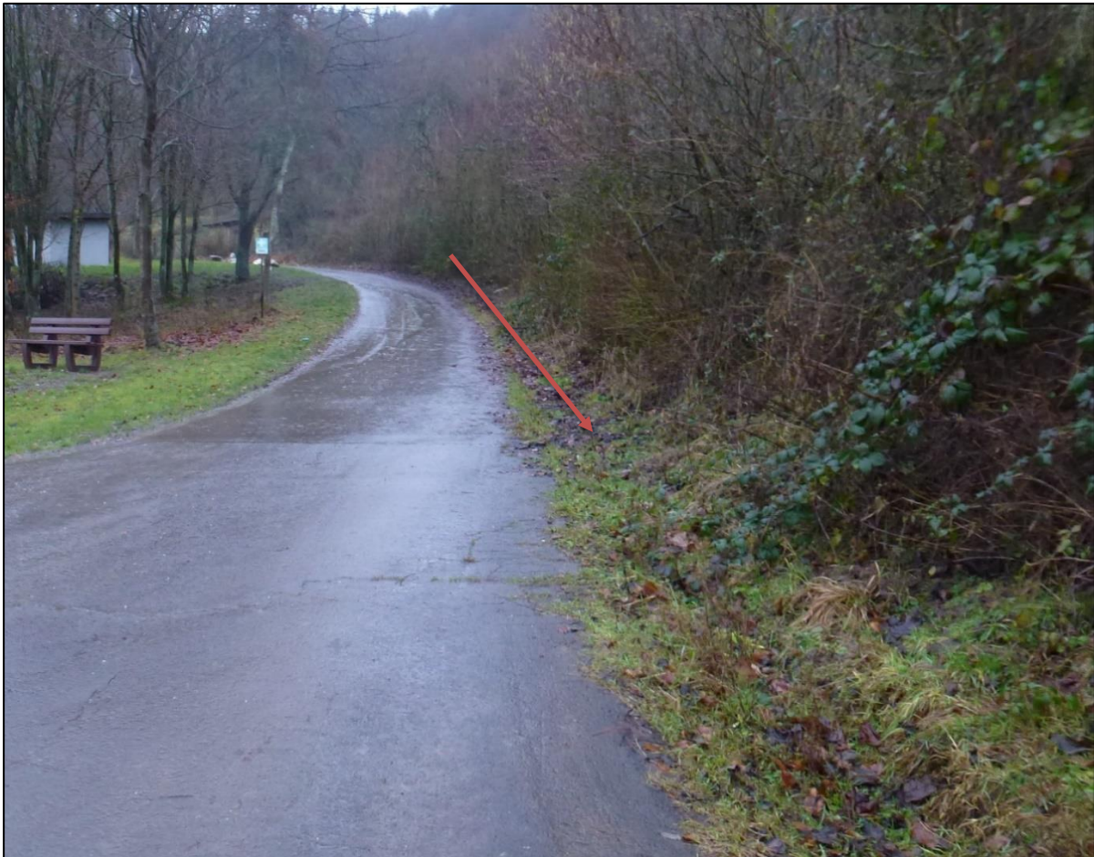
Abbildung 84: Kritischer Pflegezustand der Entwässerungsrinnen
