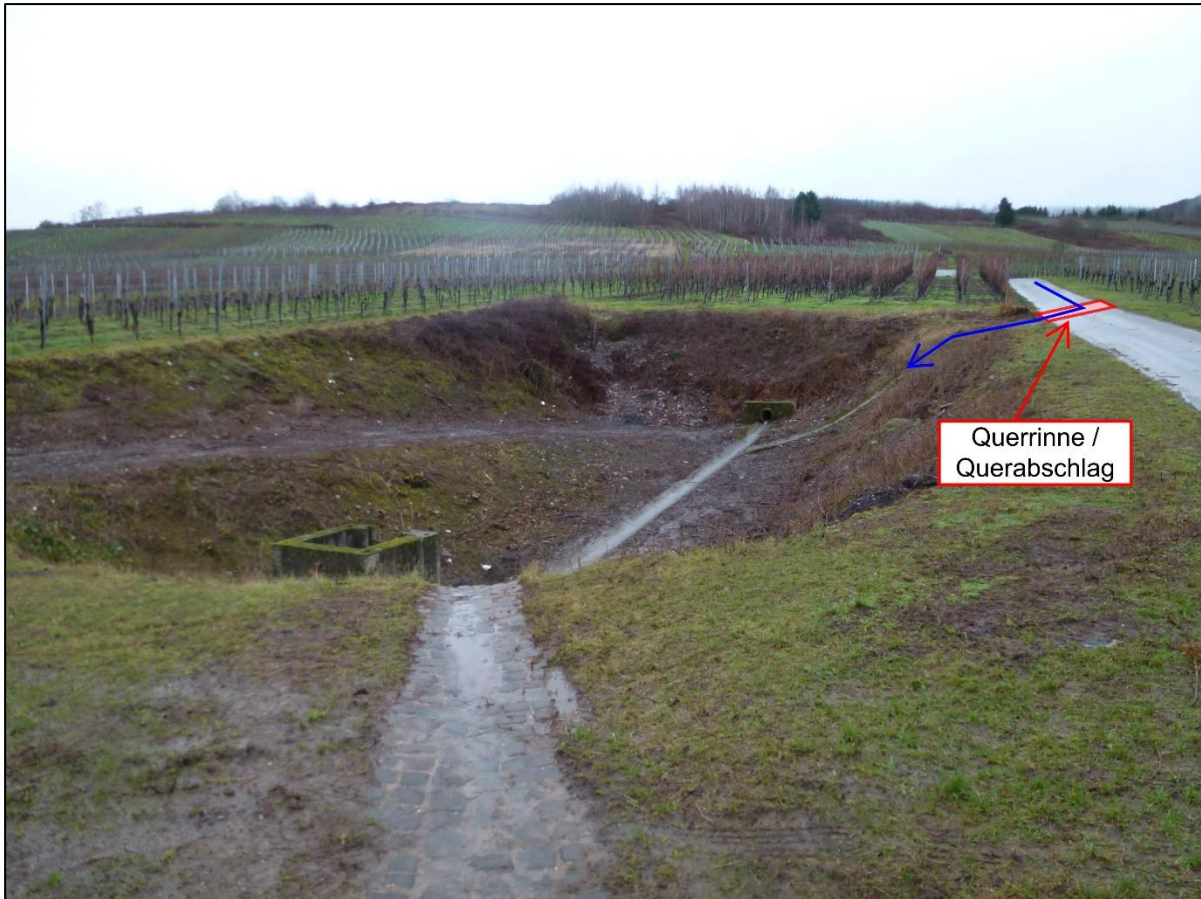
Abbildung 62: Querrinne / Querabschlag im Bereich des Regenrückhaltebeckens
