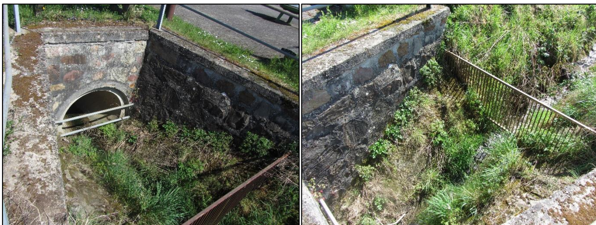
Abbildung 76: Gewässerverrohrung an der Brückenstraße
