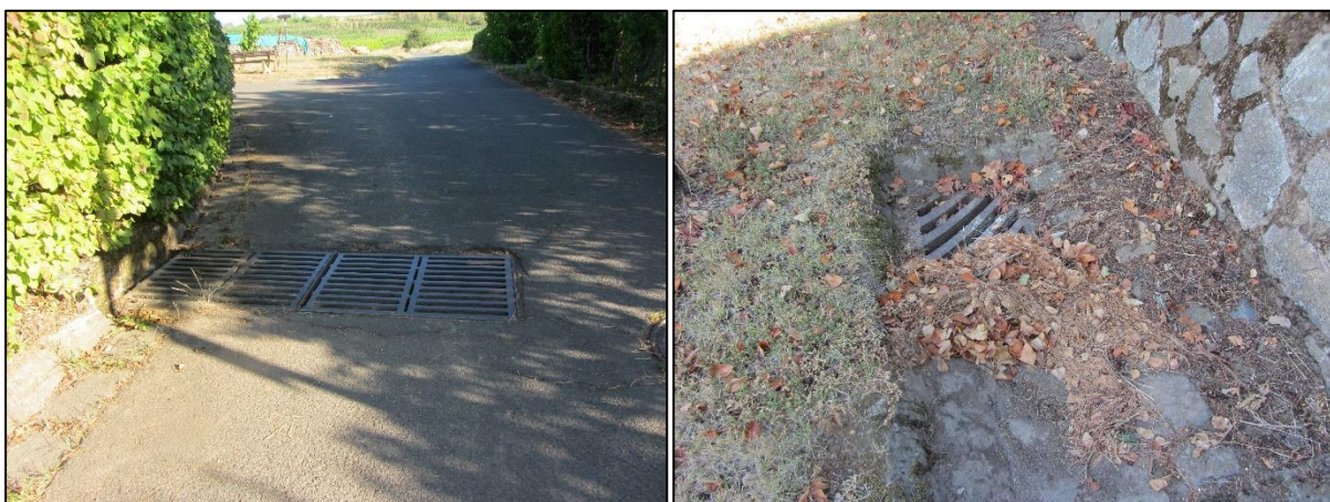
Abbildung 58: Außengebietsentwässerung im Bereich "Am Bildstock"
