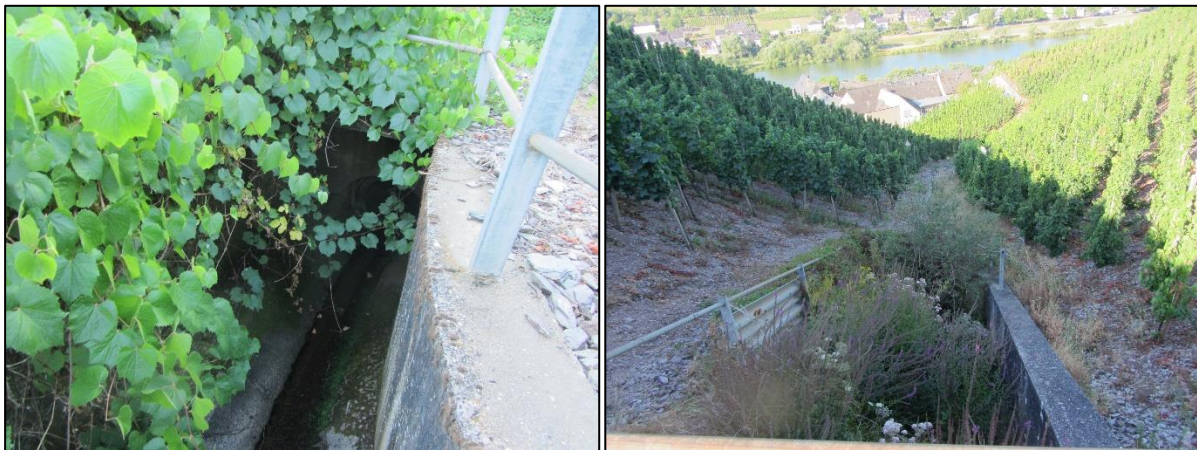
Abbildung 38: Einlaufbauwerke am Willersbach oberhalb der Bebauung
