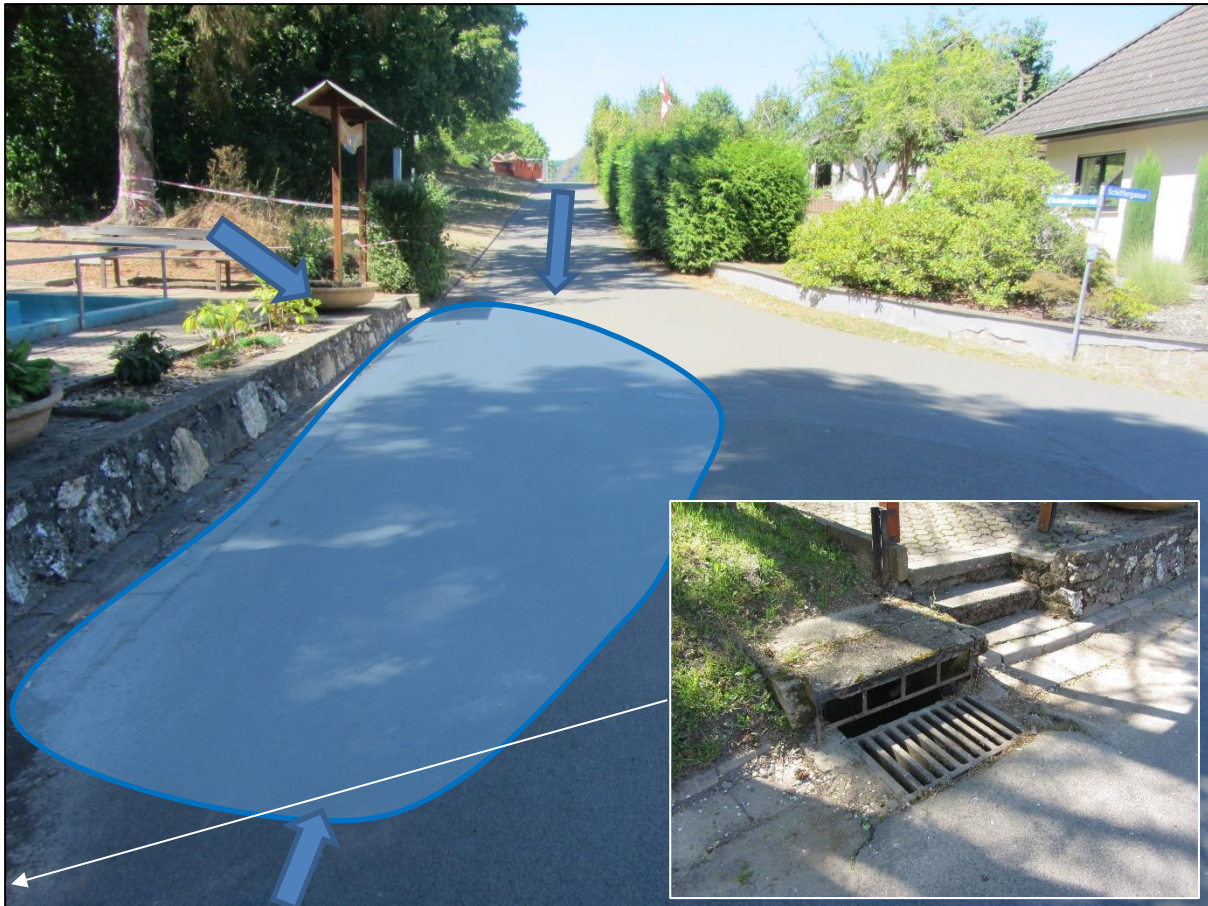
Abbildung 80: Überbogen auf Straße verhindert unmittelbares Abfließen
