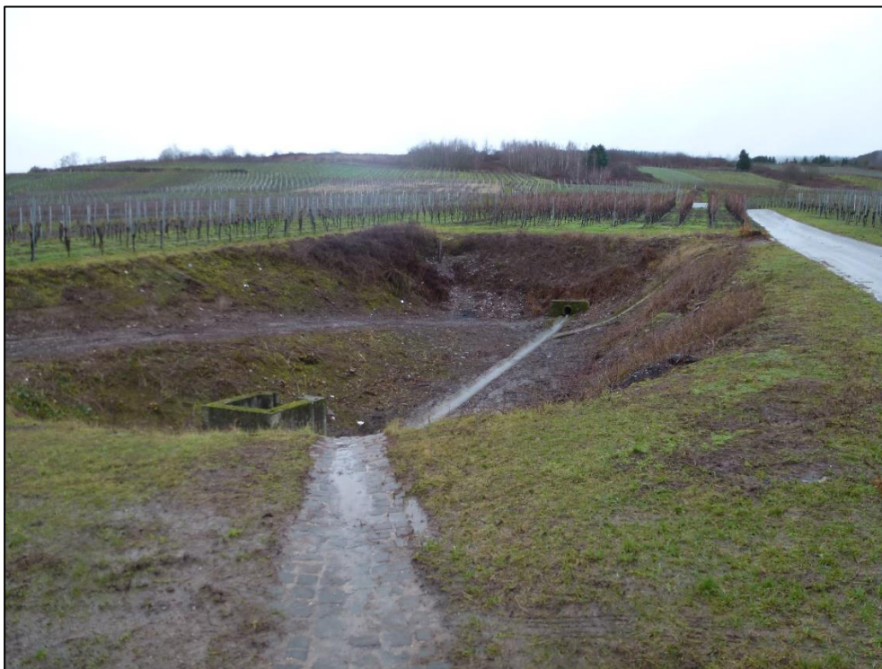
Abbildung 60: Regenrückhaltebecken während einem Niederschlagsereignis
