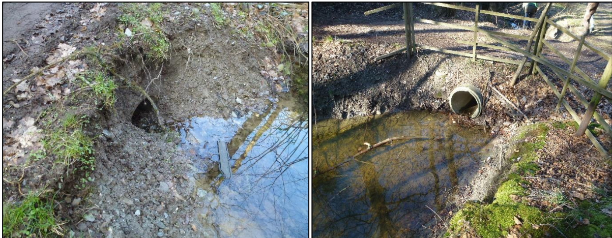
Abbildung 52: Grabendurchlass (links) und Gewässerverrohrung (rechts)
