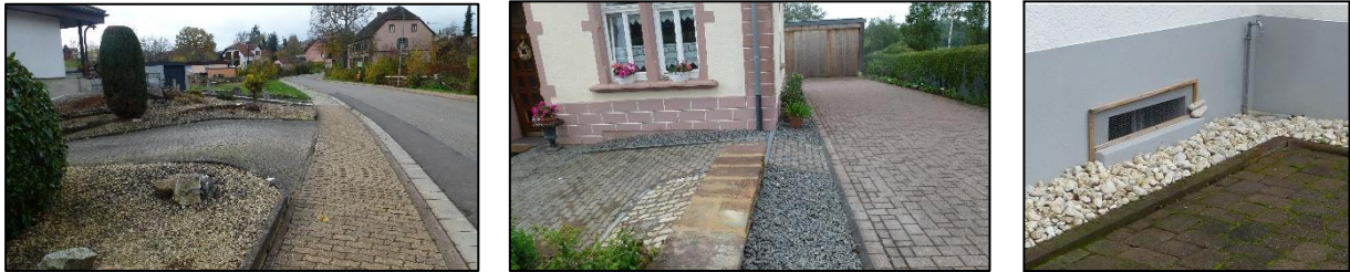
Abbildung 23: Beispiele von Objektschutzmaßnahmen (Überbogen, Geländemodellierungen, Aufkantung am Kellerfenster)
