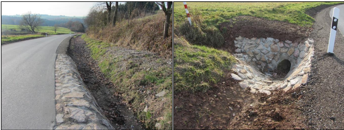
Abbildung 26: Neuer Entwässerungsgraben der K133
