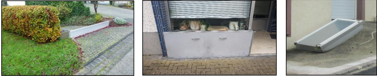
Abbildung 22: Beispiele von Objektschutzmaßnahmen (mobile Steckelemente, Dammbalkensysteme, Abdichtungen)
