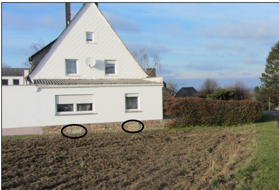
Abbildung 31: Objektschutz im Bestand
