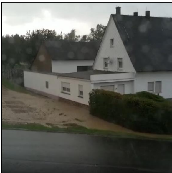
Abbildung 29: Bereits betroffenes Anwesen in der Oberstraße Hsnr. 44 (Video: Anwohner, 2017)
