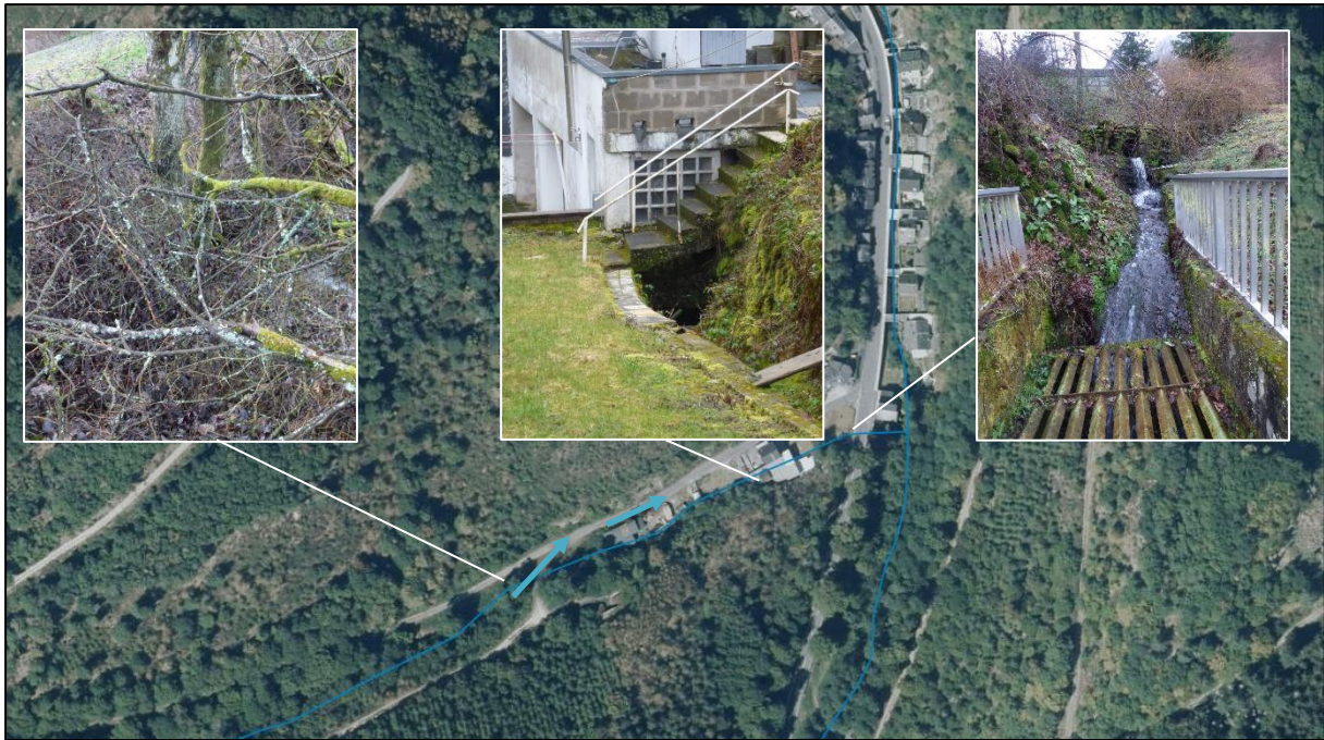
Abbildung 38: Verrohrungen am Brunnengraben
