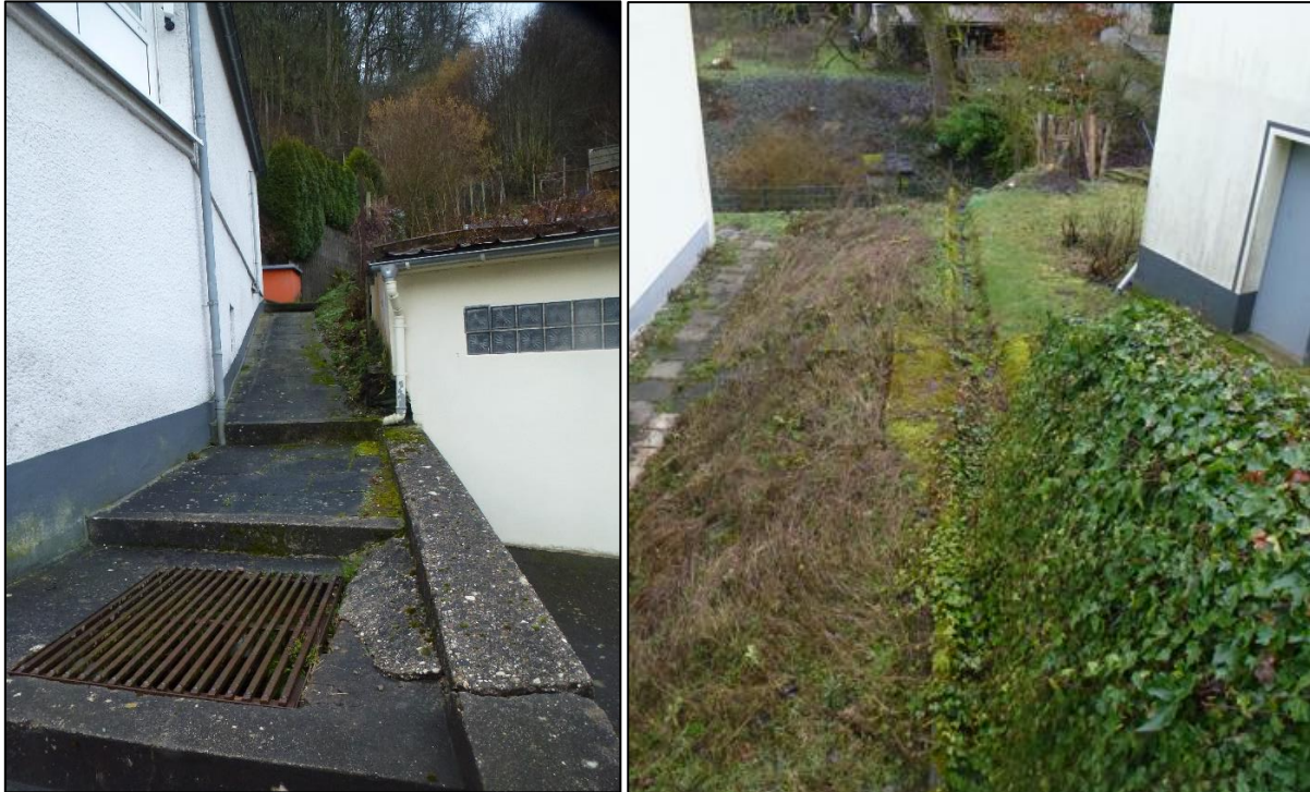
Abbildung 47: Außengebietsentwässerung in der Tiefenlinie: Einlaufbauwerk (links) & Halbschalen (rechts)
