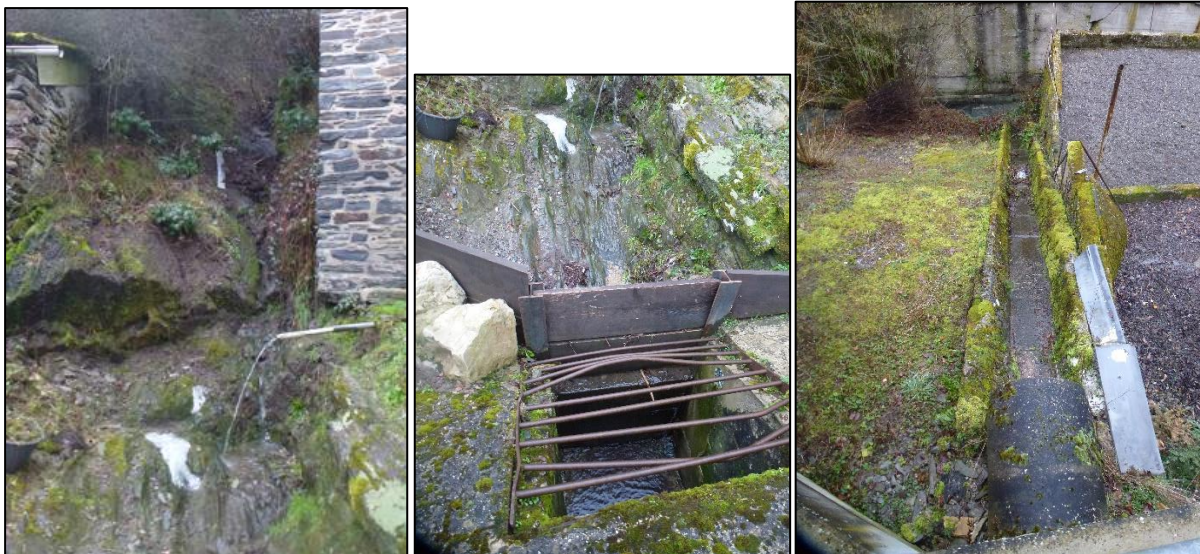
Abbildung 51: Entwässerungssystem in der Tiefenlinie
