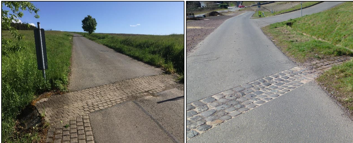
Abbildung 43: Beispielbilder für gepflasterte Querabschläge
