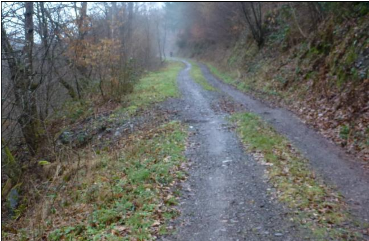
Abbildung 16: Bereits umgesetzte Maßnahme - Querabschlag auf einem Forstweg
