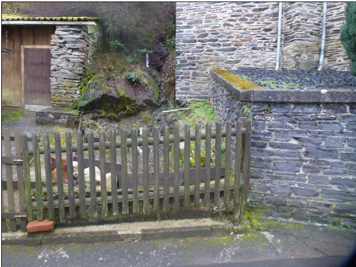
Abbildung 52: Aufkantung am Einlaufbauwerk
