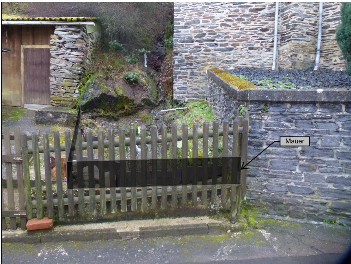
Abbildung 53: Vergrößerung des Überstauraumes mittels Mauer
