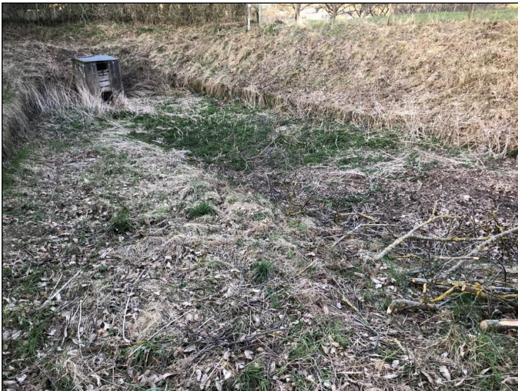
Abbildung 36: Rückhaltebecken mit Totholz (Foto: Langen, 2022)
