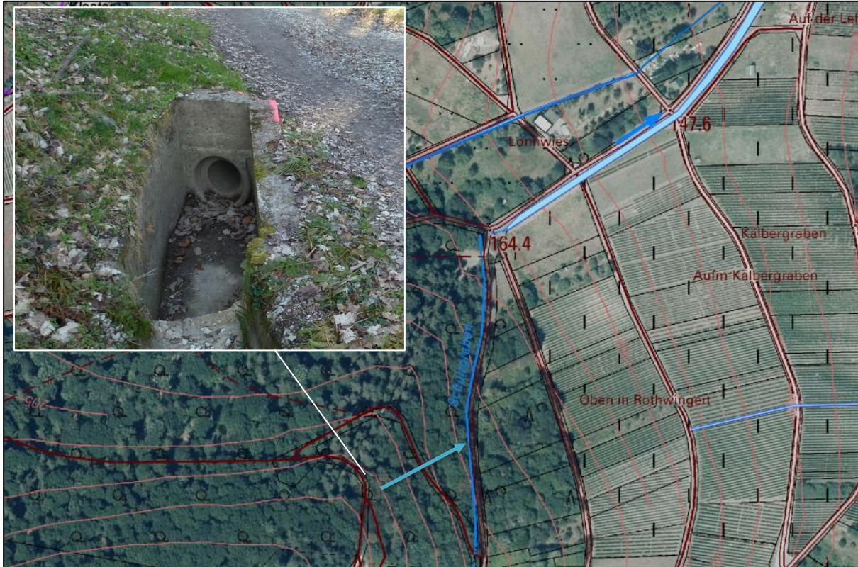
Abbildung 50: Wasserführung im „Kleinforst“
