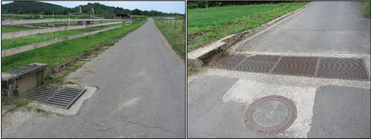
Abbildung 44: Beispiel für kleinen Straßeneinlauf (links) und Schwerlastrinne (rechts)
