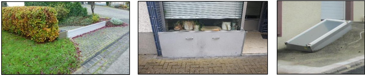
Abbildung 21: Beispiele von Objektschutzmaßnahmen (mobile Steckelemente, Dammbalkensysteme, Abdichtungen)
