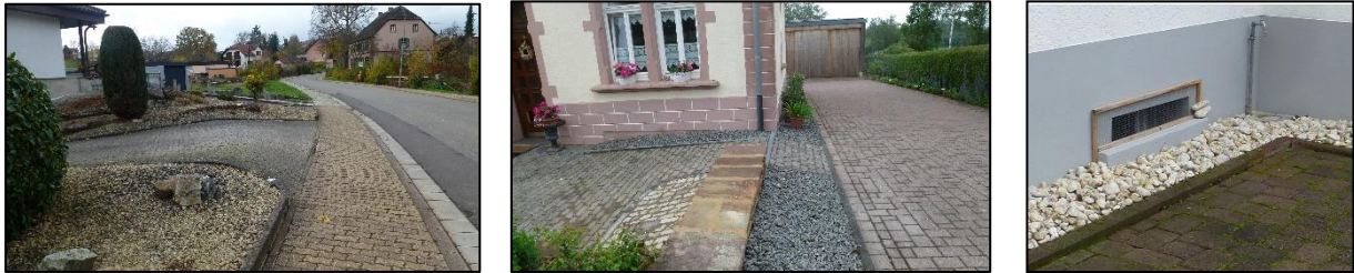
Abbildung 22: Beispiele von Objektschutzmaßnahmen (Überbogen, Geländemodellierungen, Aufkantung am Kellerfenster)
