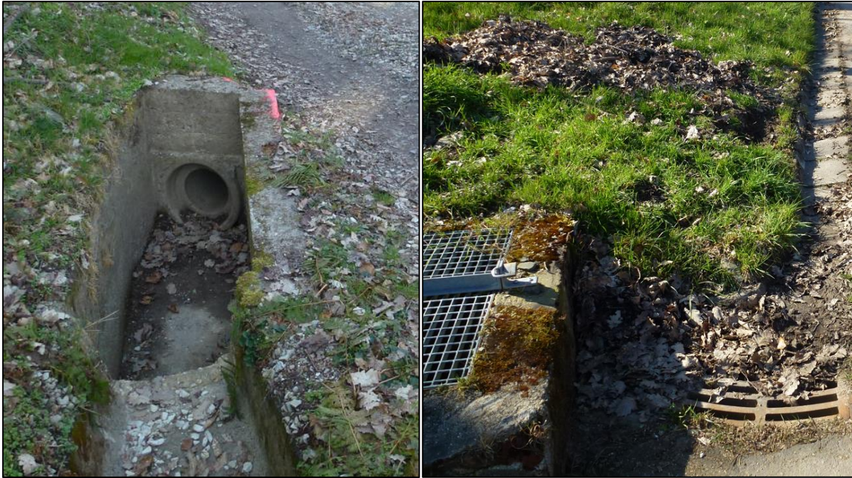
Abbildung 48: Bauwerke der Außengebietsentwässerung im „Kleinforst“
