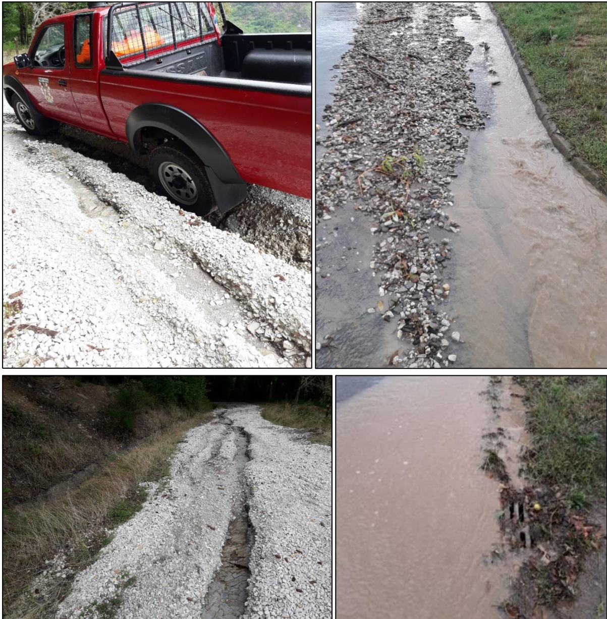
Abbildung 09: Ausgespülte Wege und Oberflächenabfluss nach einem starken Niederschlag (Fotos: Weißkopf)
