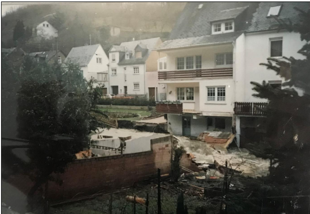
Abbildung 81: Hochwasserereignis am Kautenbach im Januar 1995 (Quelle: Anwohner)
