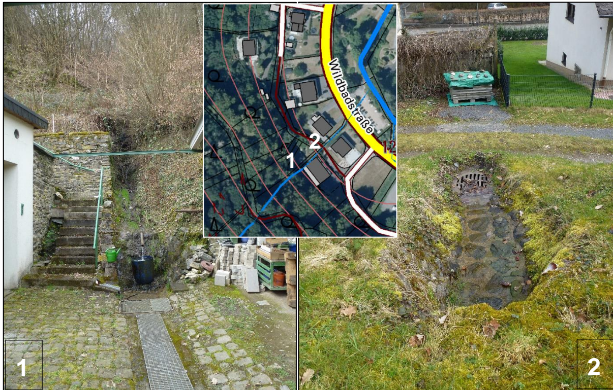
Abbildung 107: Einlaufbauwerke zu Beginn der Bachverrohrungen
