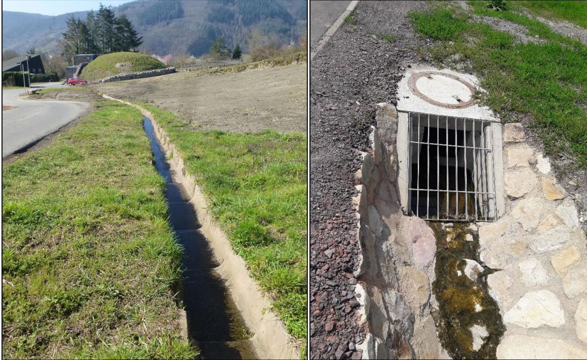
Abbildung 47: Seitengraben der Römerstraße (links) mit Einlaufbauwerk (rechts)
