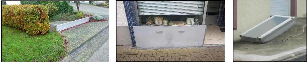
Abbildung 23: Beispiele von Objektschutzmaßnahmen (mobile Steckelemente, Dammbalkensysteme, Abdichtungen)
