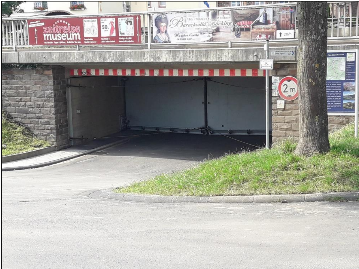
Abbildung 33: Geschlossenes Hochwassertor an einer Unterführung (Bild vom 22.07.2021)
