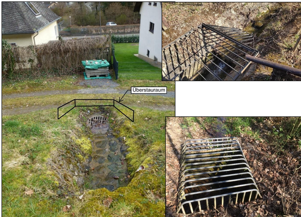
Abbildung 108: Umwandlung in ein mehrdimensionales Einlaufbauwerk inklusive Überstauraum
