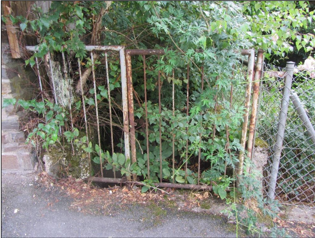
Abbildung 91: Blick auf das Einlaufbauwerk von der Straße
