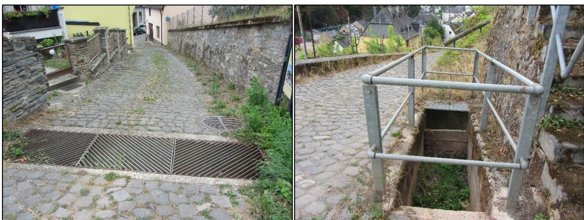
Abbildung 70: Beispiele der bestehenden Außengebietsentwässerung am Wirtschaftsweg nahe "Bernkasteler Weg"
