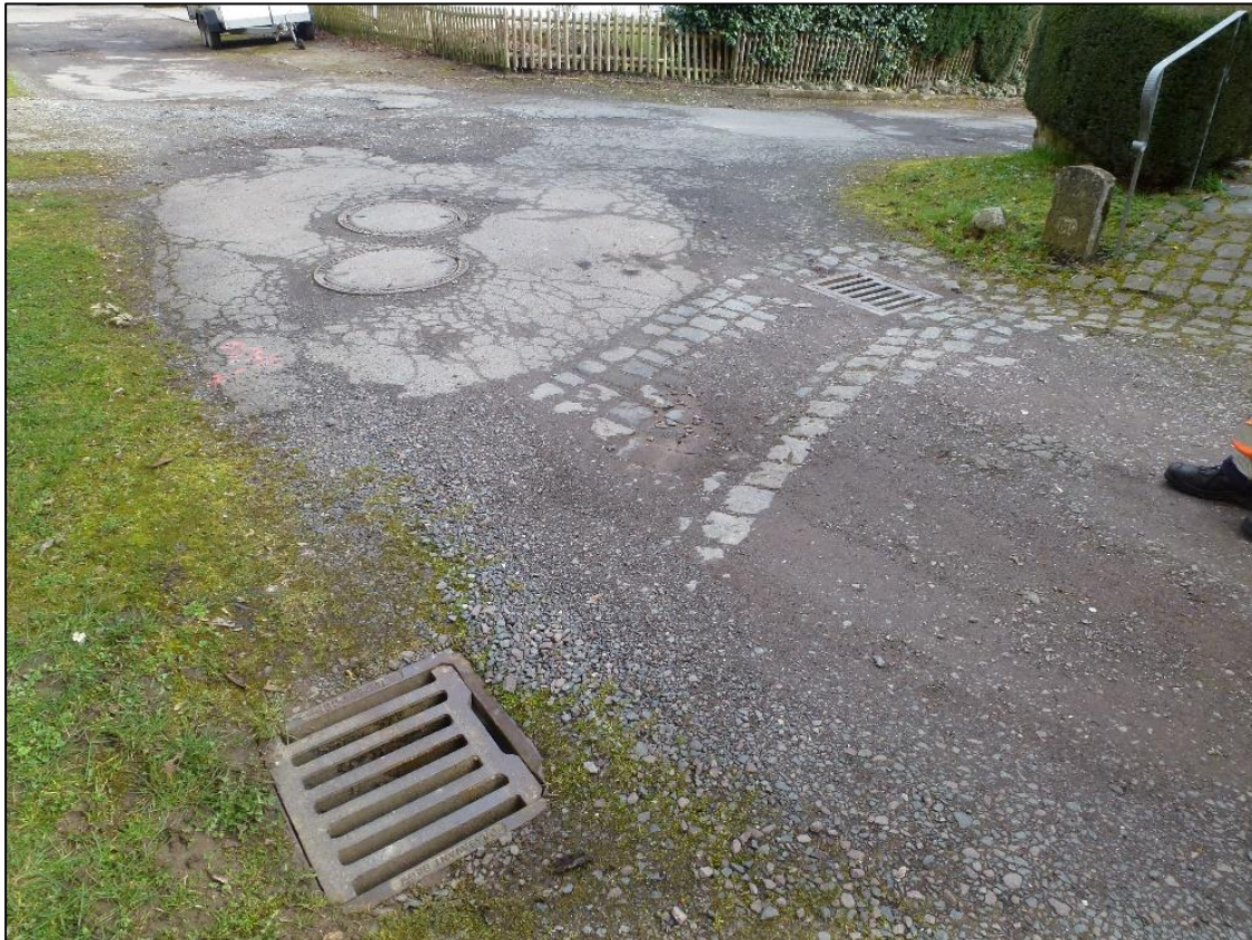
Abbildung 110: Querrinne mit Optimierungsbedarf
