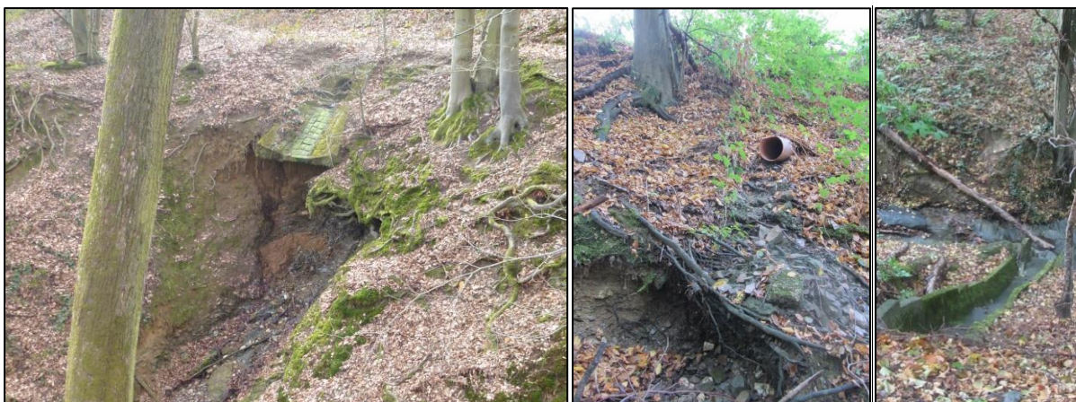
Abbildung 61: Wassereinleitungsstellen am Veitsgraben
