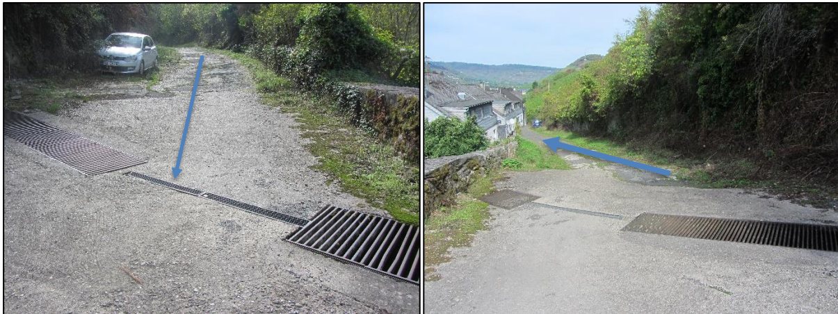
Abbildung 99: Abflussweg aus dem Außengebiet in Richtung Schottstraße
