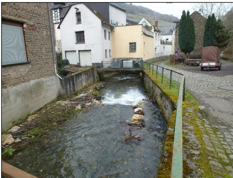
Abbildung 80: Uferverbau am Kautenbach
