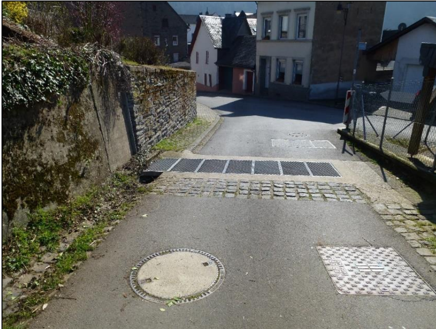
Abbildung 41: Schwerlastrinne zu Beginn der Bebauung
