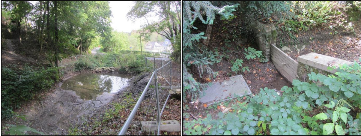
Abbildung 87: Beispiele für bereits vorhandene Geröll- und Geschiebefänge (links: "Sauerberger Bächelchen", rechts: "Compener Bächelchen")
