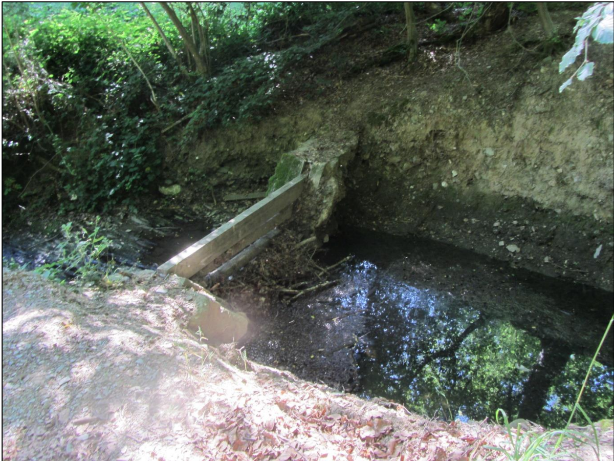
Abbildung 63: Vorhandener Querriegel im Bereich der Bahnunterführung
