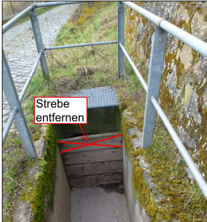
Abbildung 75: Optimierungsvorschlag am Einlaufbauwerk
