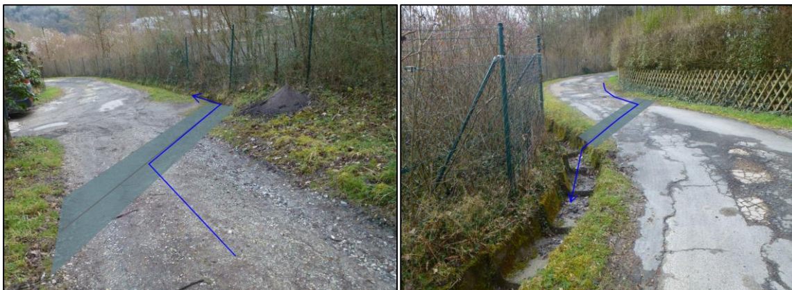
Abbildung 96: Verbesserung der Anströmbarkeit des Entwässerungsgrabens
