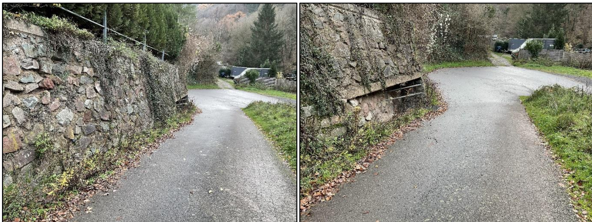
Abbildung 103: Vorhandene Außengebietsentwässerung auf möglichem Notabflussweg
